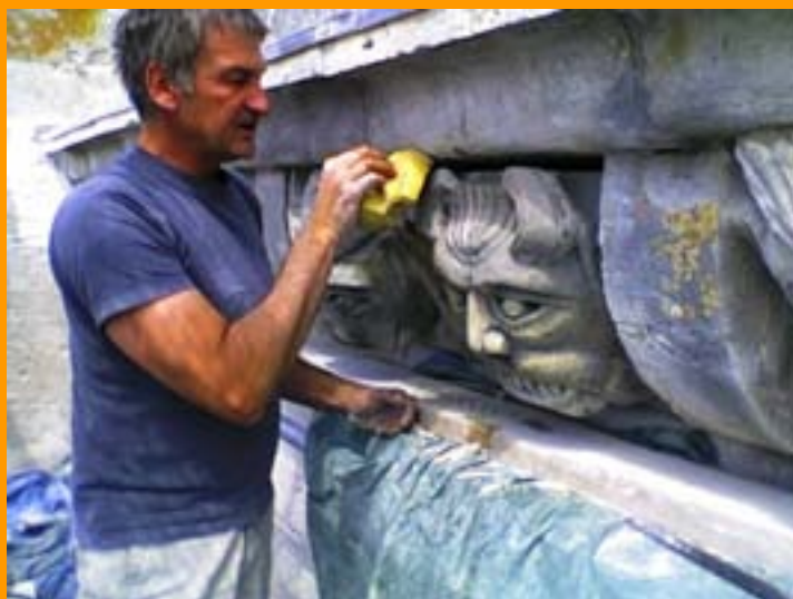
Travail de restauration (été 2010)
